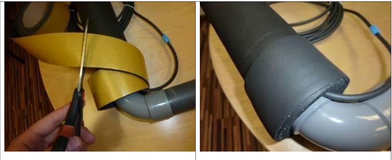
**ES DÜRFEN KEINE SCHLAUCHKLEMMEN EINGESETZT WERDEN** auf Höhe des Sensors, denn die Komprimierung auf Sensorhöhe verringert die Isolierungsfähigkeiten.
