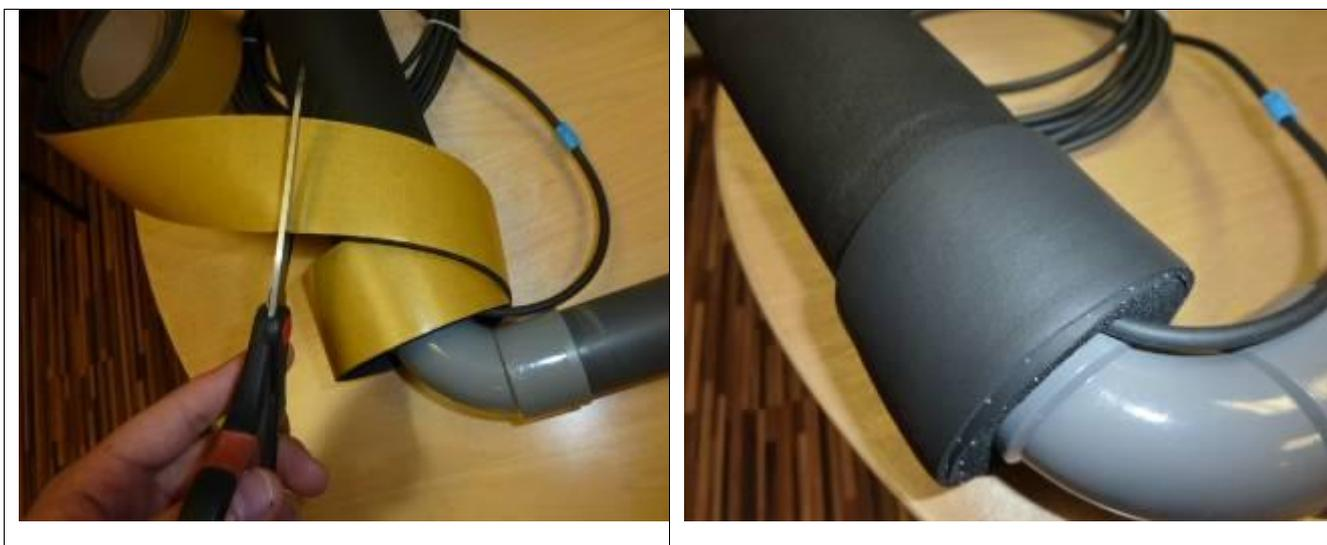
NE PAS SERRER AVEC DES COLLIERS au niveau du capteur car compresser la mousse supprime les bulles d'air emprisonnées et réduit les performances d'isolation.
