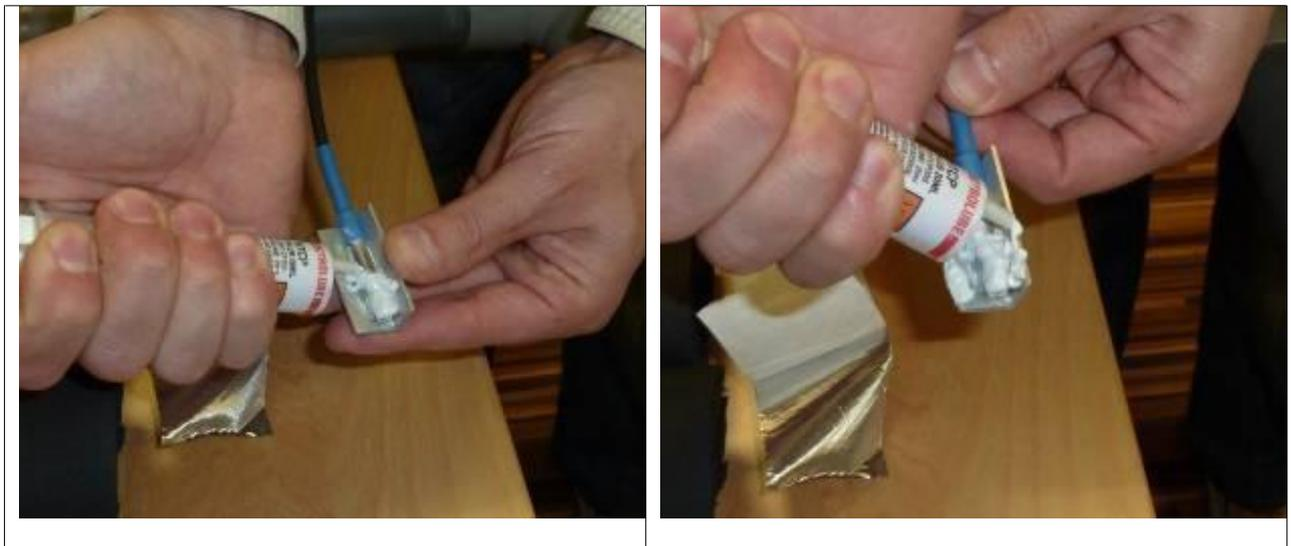
Bringen Sie das Aluklebeband auf der Sondenkappe, platzieren Sie die Kappe auf der Sonde in der Rohrrichtung und kleben Sie das Klebeband um das Rohr herum.
