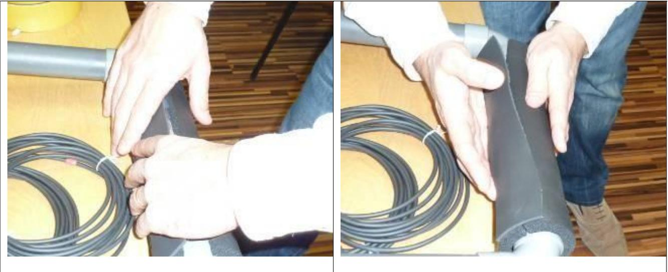
Messen Sie den Kreisumfang plus einige Zentimeter und beide Enden der Installation mit Schaumstoffklebeband dicht zuschließen, damit keine Luft reinkommt.
